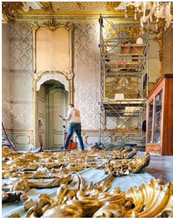
Palazzo Chiabrese durante i lavori di restauro delle decorazioni
