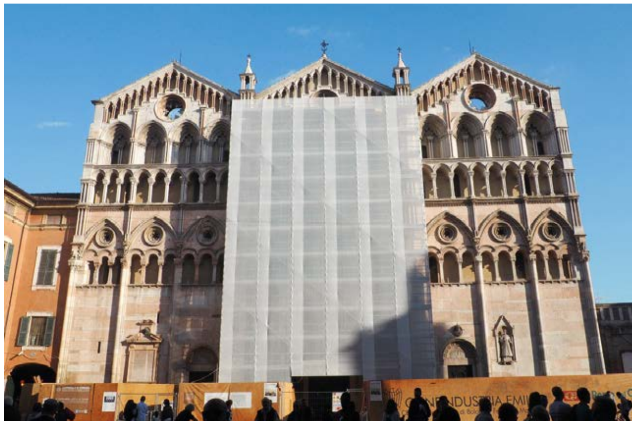
Una veduta della Cattedrale di Ferrara con i ponteggi
