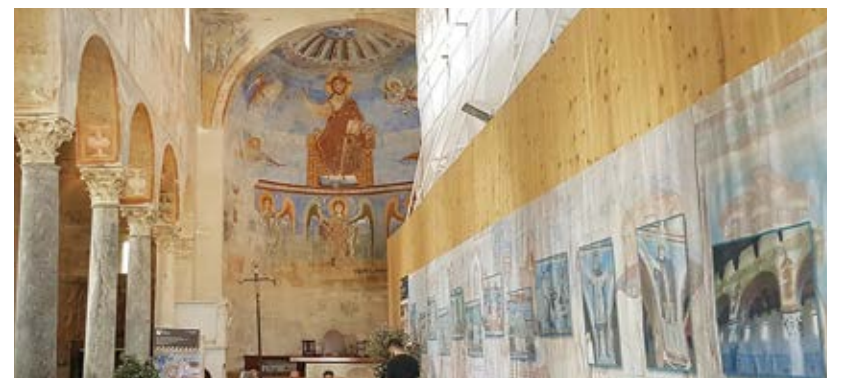
La navata centrale di Sant'Angelo in Formis a Capua durante i lavori
